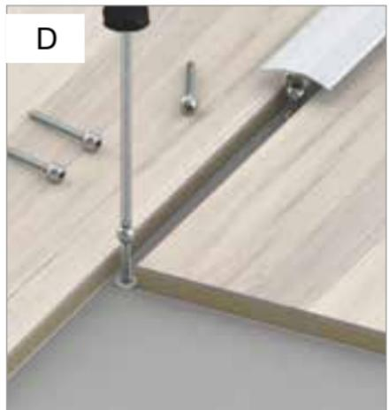
Hinweis: Das Abschluss-Profil 27 mm ist in Verbindung mit der Kugelschraube nicht als Treppenprofil geeignet.
