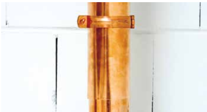
Vollrunde Biegung eines Kupferblechs. Hier: Verlängerung oder Reparatur von Kupferfallrohr bzw. Abzweigung für Regenwassersammelbehälter. Tipp: Seitliches Loch schon vor der Biegung in noch flaches Kupferblech einbringen.
